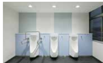
铁道设施 京阪电气铁道 西三庄站
